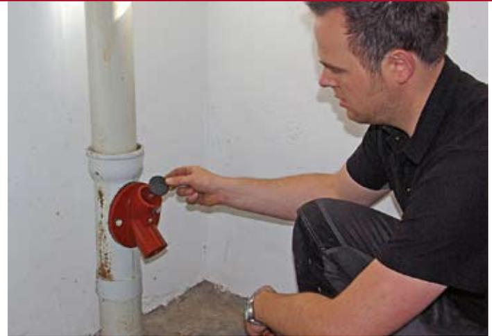
■ Nachdem die Verstopfung beseitigt wurde, muss noch eine neue Abdichtungsmembrane in die untere Kammer des Anschlusses eingelegt und anschließend das Kammerzwischenstück eingeschraubt sowie die Verschlusskappe aufgesetzt werden.
