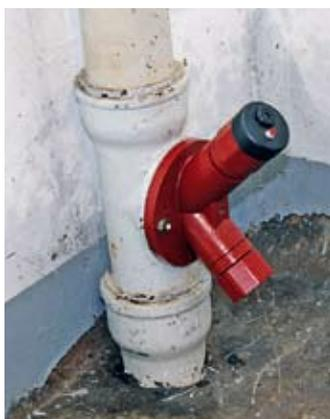
■ Die neue innovative Lösung für die abwasserkontaktlose Reinigung und Sicherung des Systems, zur Vermeidung von Abwasserüberschwemmungen im Gebäude. Der „Putz-Fix“ kann sowohl senkrecht als auch waagrecht in Leitungen eingebaut werden.
