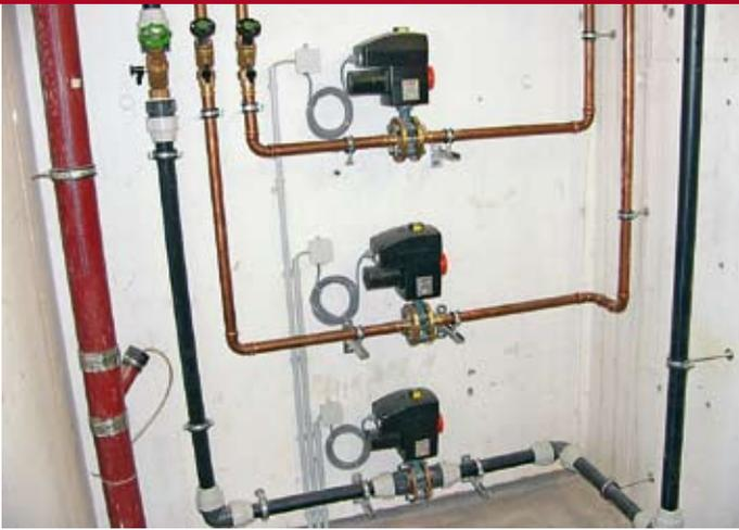
■ Wenn ein Rückstau länger als zehn Sekunden am Drucksensor ansteht, wird in der zweiten Sicherheitsebene die Wasserzufuhr mittels motorbetriebener Absperklappen unterbrochen.
